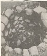
手積み小口石の自然石法で作られた古井戸
