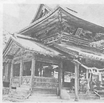
解体前の古熊神社拜殿(昨年2月撮影)
