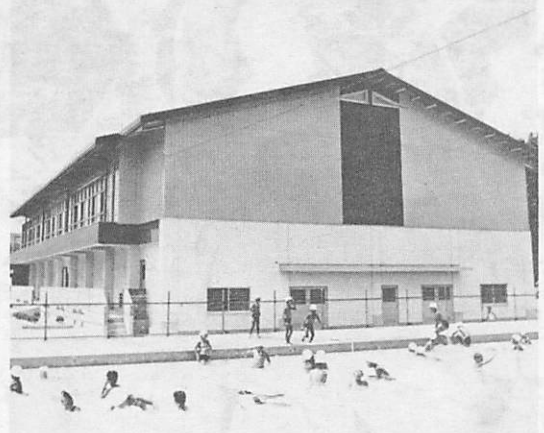
レンガ色の屋根に、アイボリー色の外壁。しっかりと落ち着いた二島小学校屋内運動場
