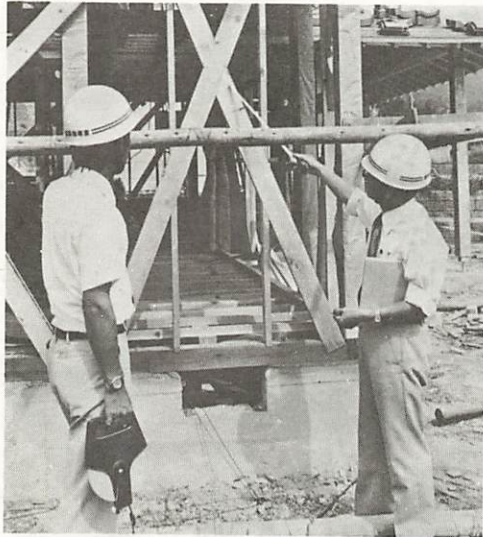
建築法規に適合して建築されているかどうか、現場を確認して違反防止に努める係員
