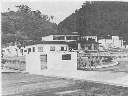
10月29日の竣工式を待つ、し尿処理場「山口県中部環境センター」
