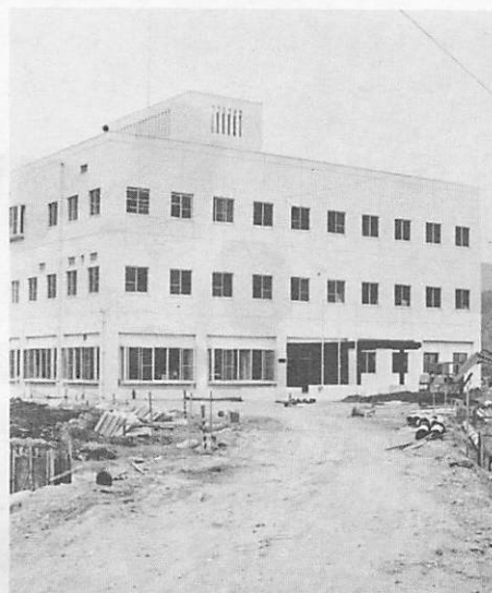
12月からの通水開始をむかえ、急ピッチで工事がすすむ、浄水センター本館管理棟(平川)
