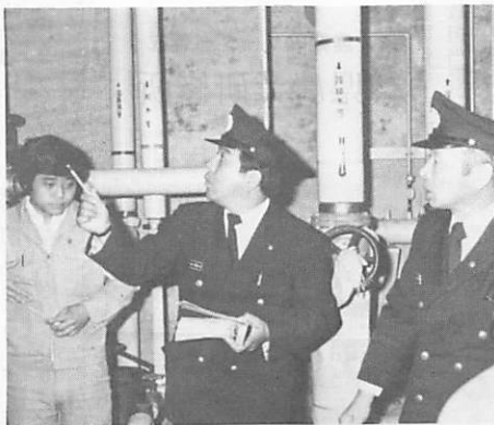
市民の安全を願って、旅館の消防設備の点検が慎重に行われます
