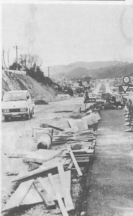
この夏、吉敷木崎から県庁前まで供用開始の 予定で工事が進む、国道9号山口バイパス
