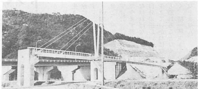
経済性と美観を考慮して、わが国で最初に架設された斜張補剛型式の仁保川水管橋
