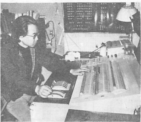
舞台上手の2階に位置する調光室で、照明の調整をしている係員
