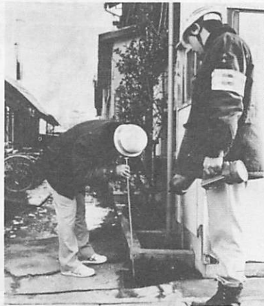
人や車が少なくなった夜中に、探知棒を耳に当てて、2人1組で漏水調査をする水道局職員
