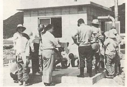
完成したポンプ小屋。中には2基のポンプが設置されています
