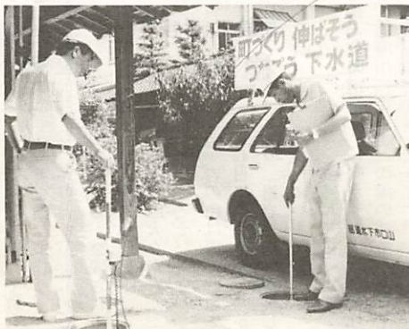
家庭の排水工事が完成し、パイプの接続検査やレベル検査を行う下水道職員
