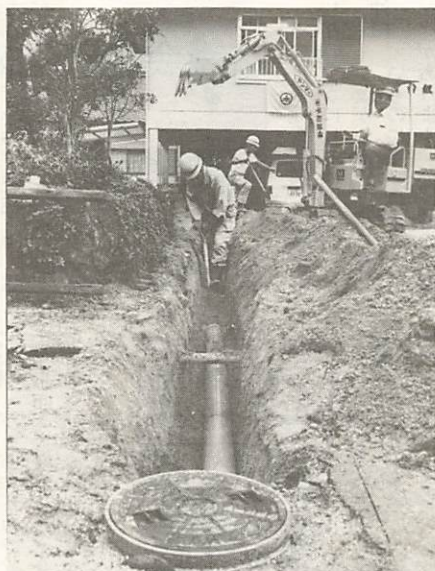
便所の水洗化、台所・風呂の雑排水を下水道管に接続する工事が急ピッチで進みます
