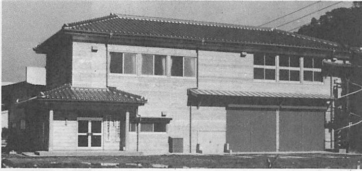
▲新築された徳地町林業センター
