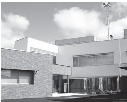
新しくなった建物
