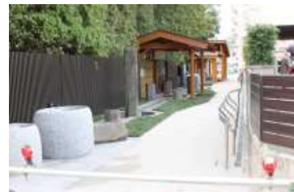
湯の香通りの整備 (令和元年10月完成)
