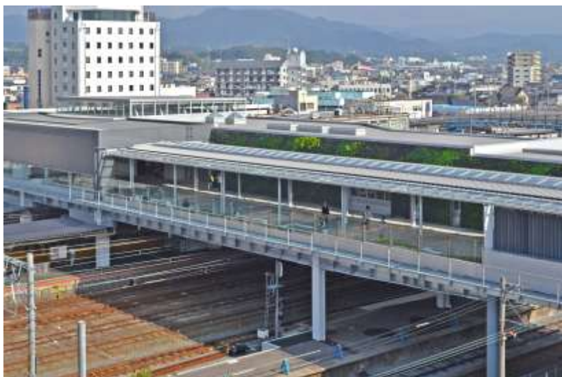
南北自由通路、橋上駅舎（平成27年10月供用開始）
