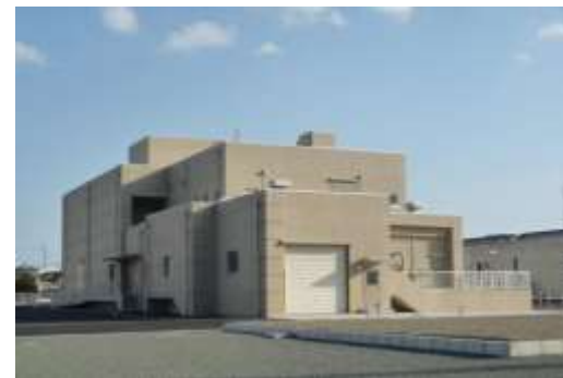
長谷ポンプ場の整備(平成31年3月完成)
