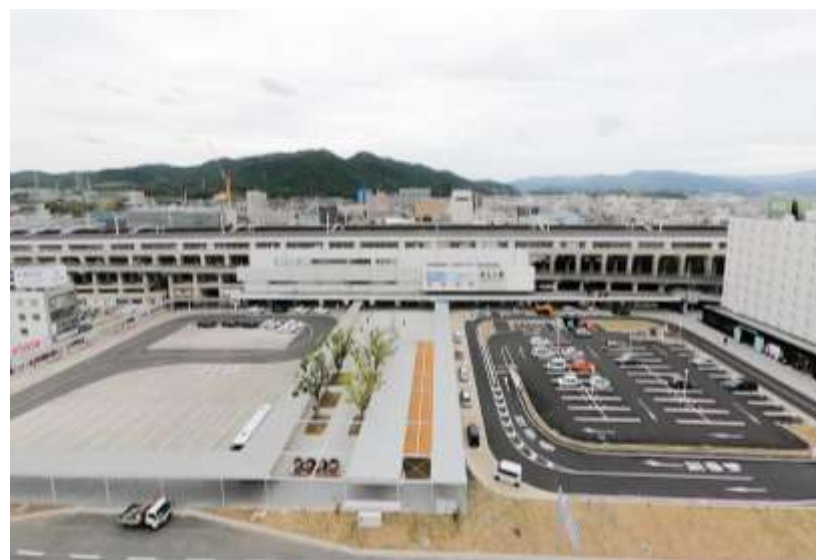
南口駅前広場（令和2年9月完成）
