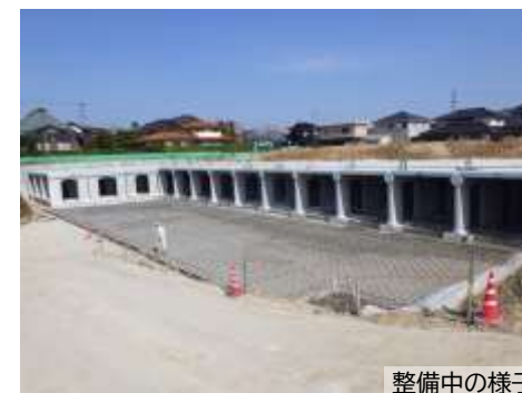
整備中の様子 赤妻2号雨水貯留施設の整備 (令和3年度完成)
