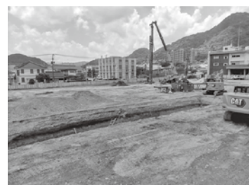
調査中の新本庁舎建設予定地
