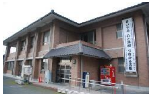
吉敷地域交流センター H23増築
