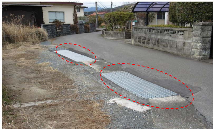
法定外公共物整備事業（大内地域） 写真は、破損したグレーチングを改修し、その周辺を舗装したものの。 通学路や人通りの多い道から優先的に実施している。
