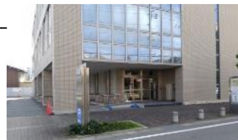
白石地域交流センター H17建設
