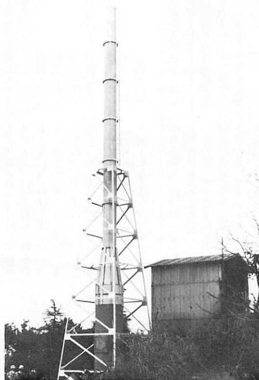
▲改修された焼却場の煙突
