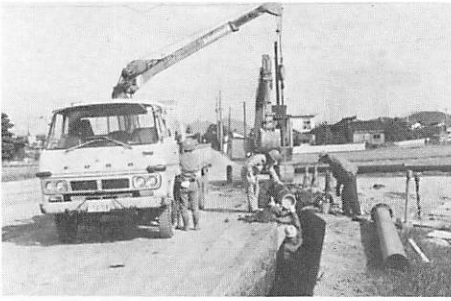
配水本管の布設工事
