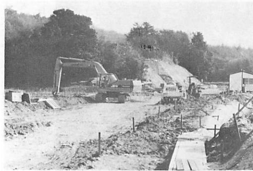
縦貫線改良工事
