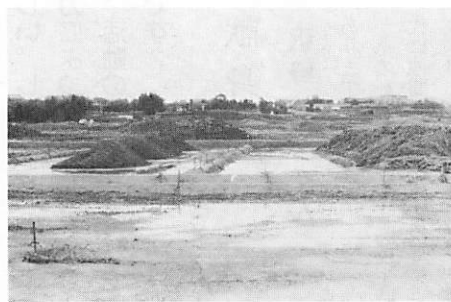
河内地区ほ場整備工事
