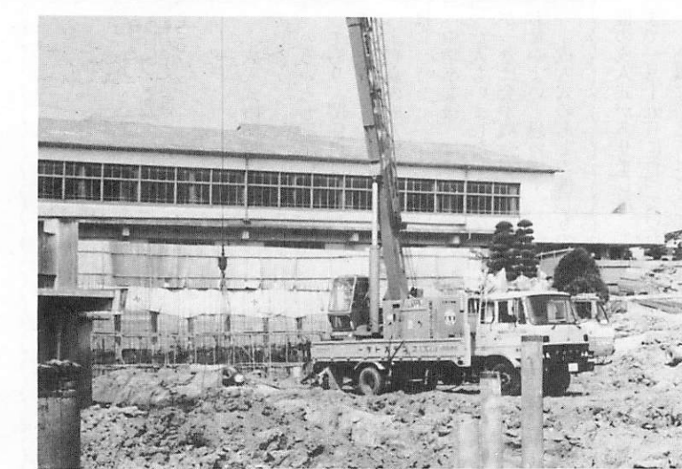
阿中校舎改築工事Ⅱ写真上
