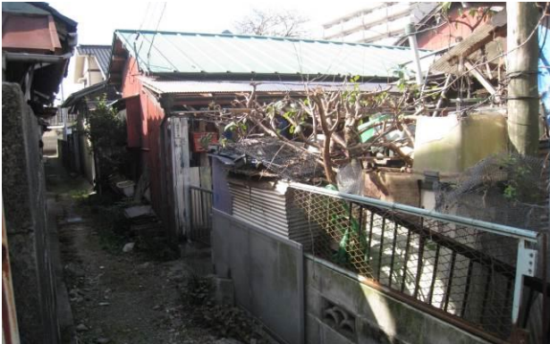
⑤無接道の老朽住宅
