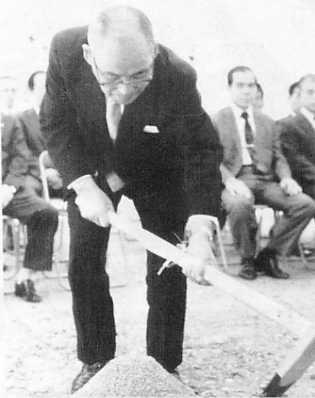
▲工事の安全を祈り、くわ入れの儀を行う三好町長（9月27日起工式）
