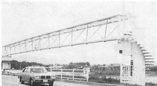
土路石川にかかる水管橋
