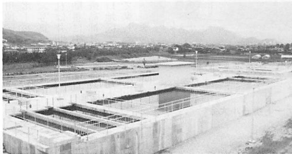
不純物を沈でんさせる沈でん池
