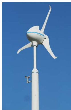
小型風力発電設備 (清掃工場エリア)
