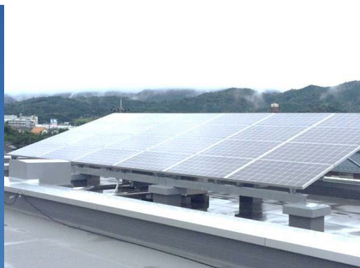
太陽光発電設備【6.36kW】 (大歳地域交流センター)
