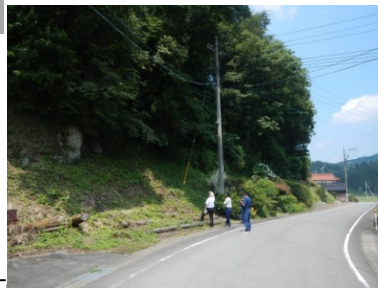
落石危険箇所一斉点検
