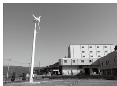
小型風力発電 <リサイクルプラザ駐車場内>
