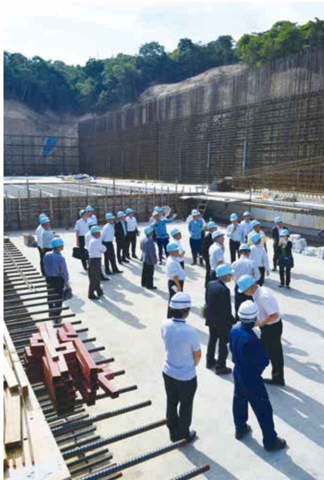
建設中の最終処分場貯留槽（山口市江崎地内）
