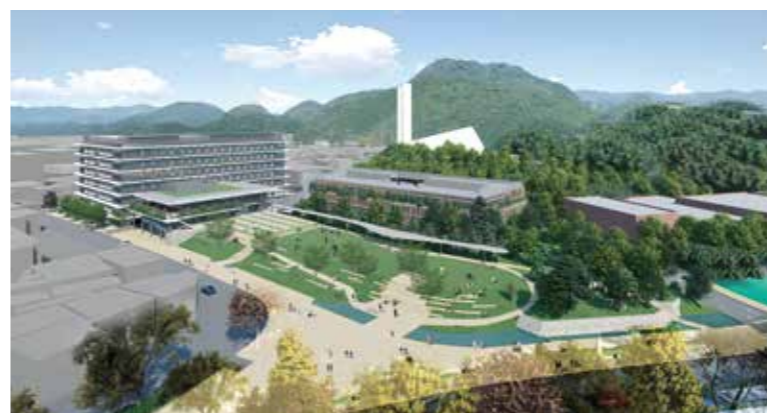
新本庁舎の整備(R6竣工予定)
