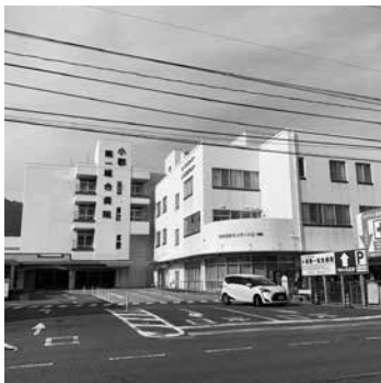
小郡第一総合病院
