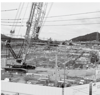
建設中の新山口駅北地区拠点施設 (12月)
