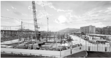
工事が進む産業交流拠点施設
