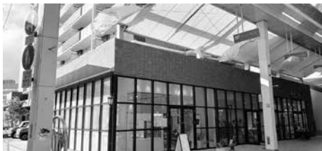
中市商店街のマンション1階の店舗の事例
