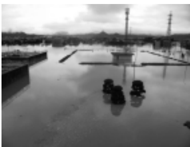
冠水した朝田浄水場
