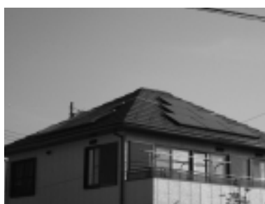
住宅用太陽光発電システム
