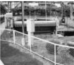
長谷下水ポンプ場
