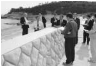
秋穂地区海岸補強工事現場
