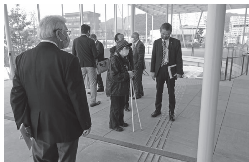
床面（グレー）と誘導ブロック（シルバー）の色（輝度）の差がないため視認しづらい
