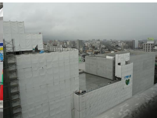
建設中の第一庁舎及び芸術館
