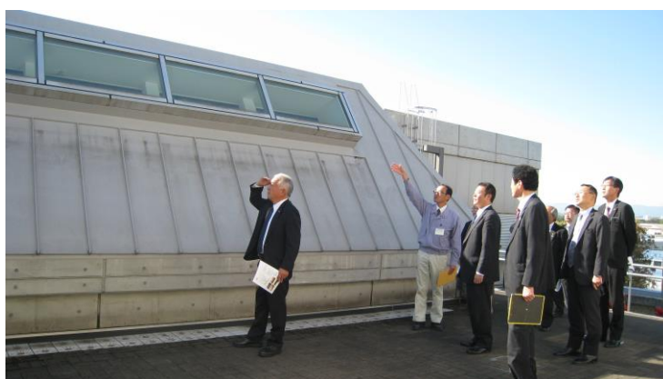
【視察の様子(立川市庁舎4階塔屋・機械室)】
