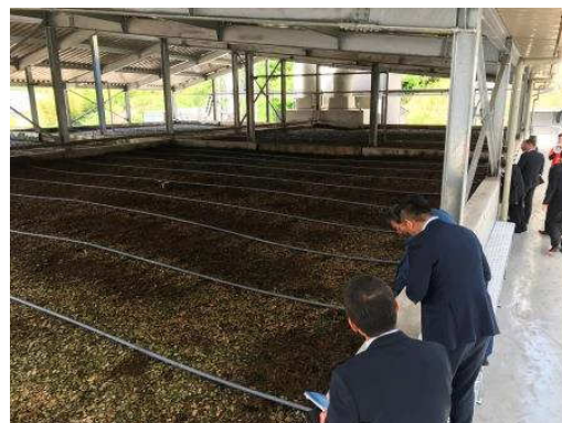
右：バイオフィルター（脱臭装置）
