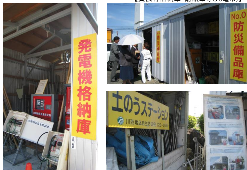
【資機材格納庫・備品庫等(丸亀市)】
