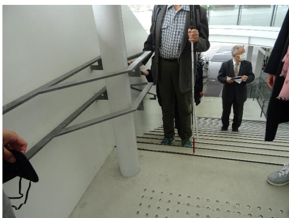
階段の下りはじめ、上り下り途中に急角度で横移動する必要があるので危険
