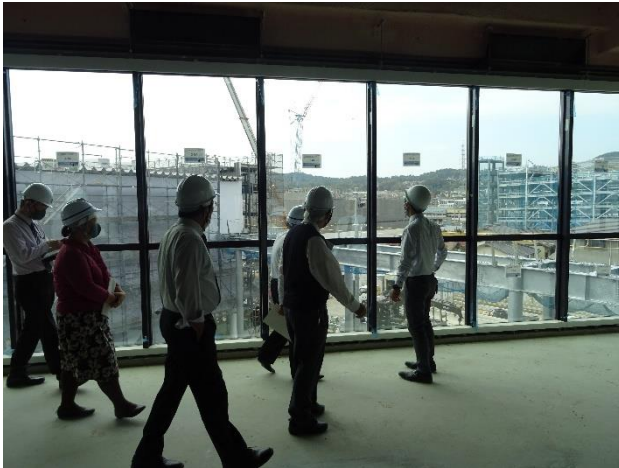
テナント入居部分と周辺（立体駐車場等）の整備状況を確認
