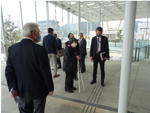
床面と誘導ブロックの色（輝度）の差がないため視認しづらい
