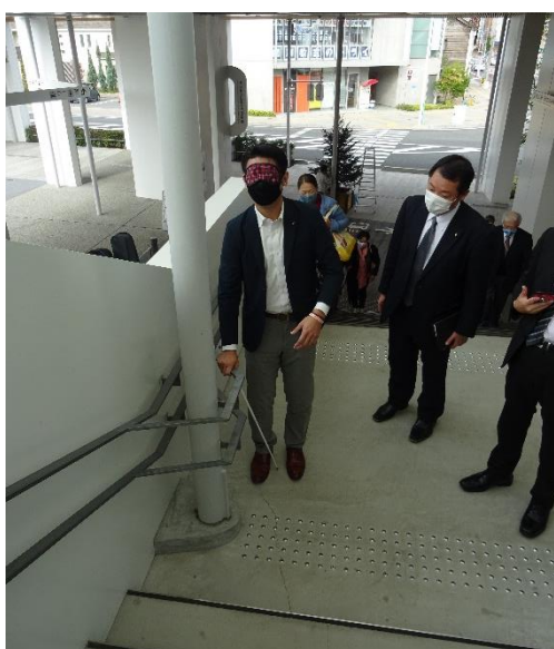
支柱回避のため手すりを改修された箇所
