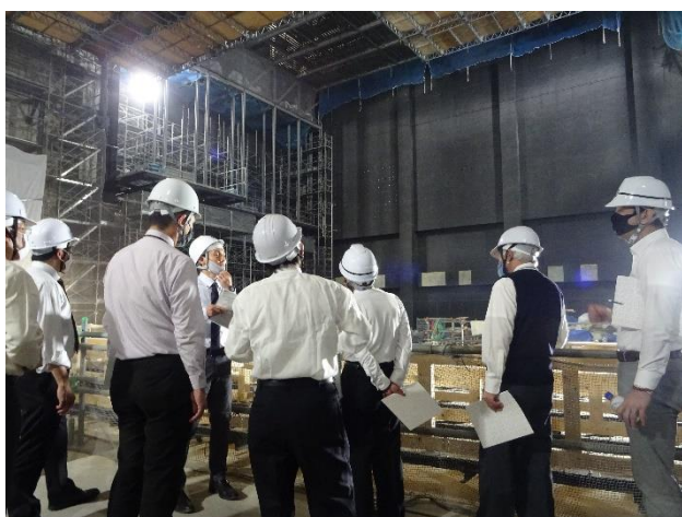
多目的ホールの平土間部分で可動床や舞台の説明を受ける
