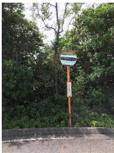
安全対策として設置されたアドバンスミラー
