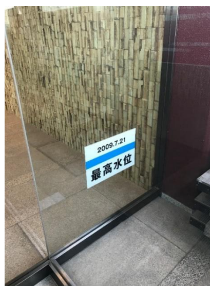
浸水時の水位を示すプレート
