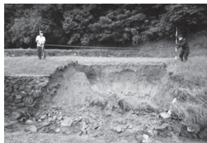
崩壊箇所の調査
