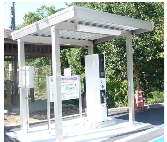
道の駅長門峡 急速充電器
