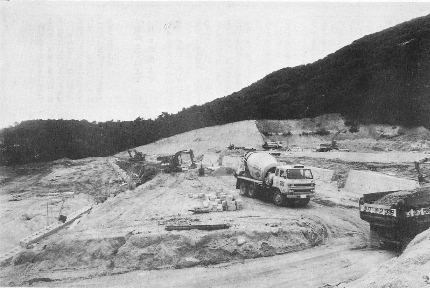
進む団地造成工事。来春に売り出し
