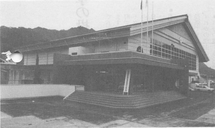
▲完成した町民体育館
