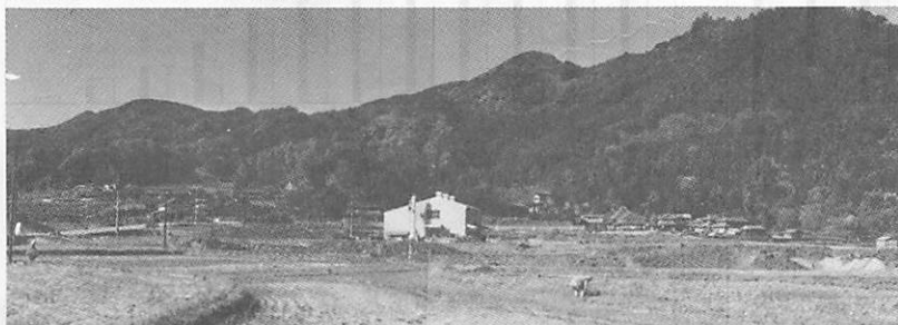
ほ場整備が行われる下津屋地区
