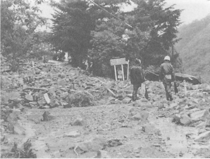
土石流は民家や道路に大被害をもたらします
