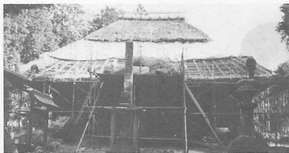
屋根のふきかえ工事中の月輪寺薬師堂
