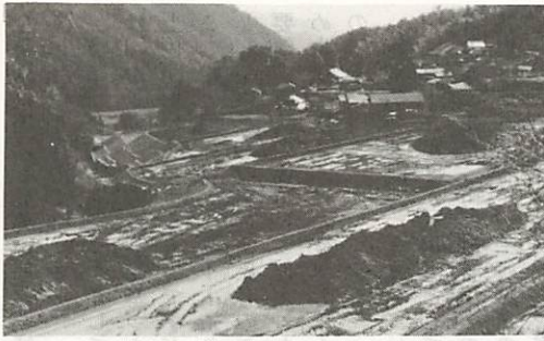
河内地区の進む場整備
