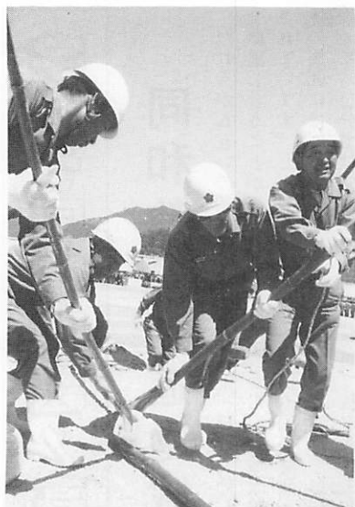
佐波川水防演習(5月15日) 町消防団員による堤防亀裂 を防ぐ「折り返し工」
