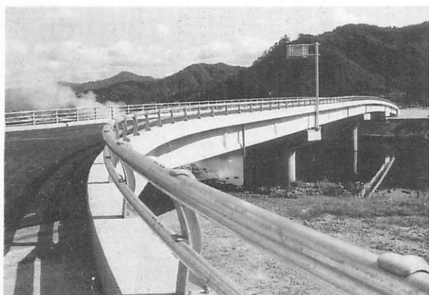
過疎代行 (町道の施工を県が代行して行う) 完成間近町内で一番長い橋「二の宮大橋」延長160.85m幅員9.75m
