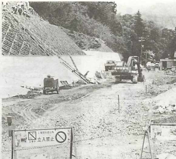
55年度から街路事業を進めている、黄金町野田線。58年度は、約8,520万円余りを投入して、春日町地内の街路180mの整備舗装を進めます
