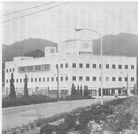
総事業費117億円を投入して、56年12月に待望の供用開始をした公共下水道(写真は管理本館棟)
