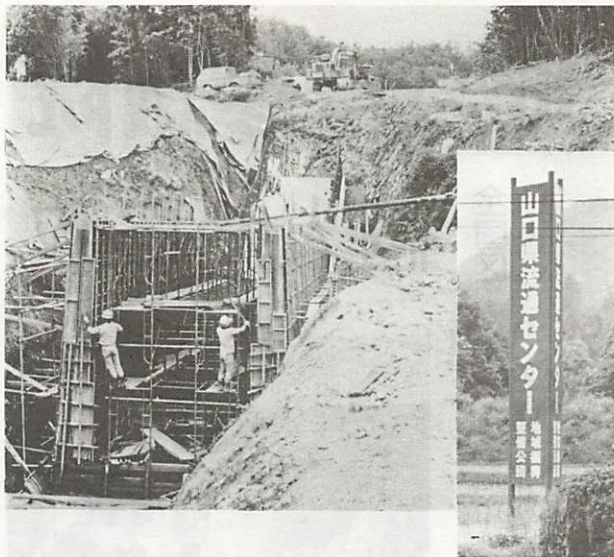
防災工事の進捗とともに幹線道路工事が進む山口県流通センター工事現場。流水量の調整に備え、朝田川などの河川改修も行われています
